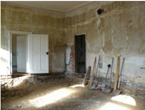
Boden auskoffern im Bürgermeister- zimmer
