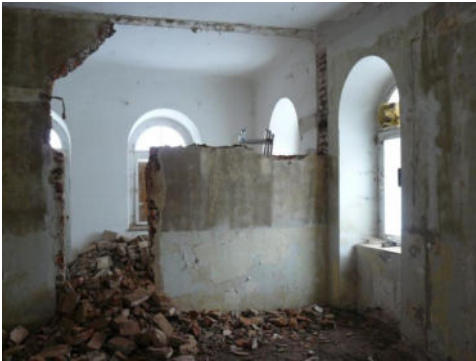
Trennwandabriss zwischen ehemaliger Küche und Bürgermeister- zimmer
