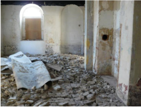
Fußboden entfernen in der ehemaligen Gasstätte
