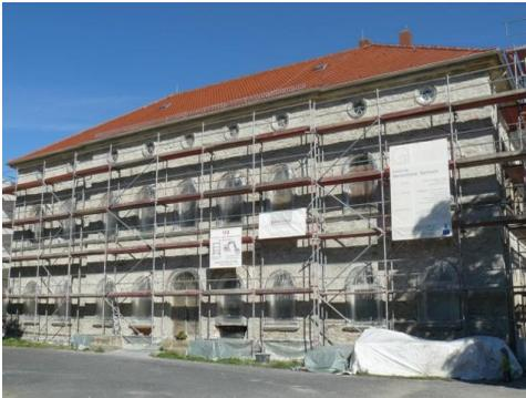
Beginn der Fassadensanierung mit Abputzen des alten Putzes
